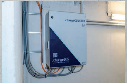
chargeCLUSTER Vorkonfigurierte Unterverteilung
