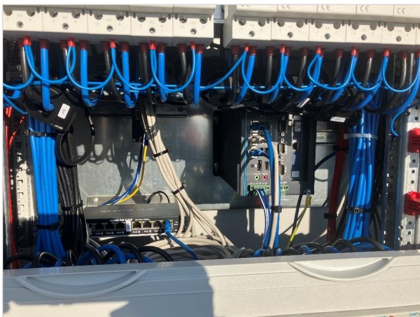
Abbildung 3 - Vorkonfigurierte Netzwerkverkabelung
