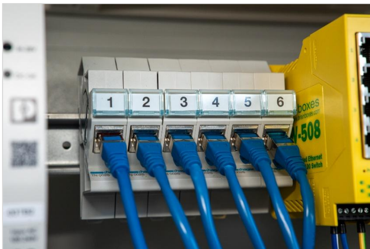
Abbildung 4 - netzwerkseitig nutzbare RJ45-Patchmodule im chargeCLUSTER L
