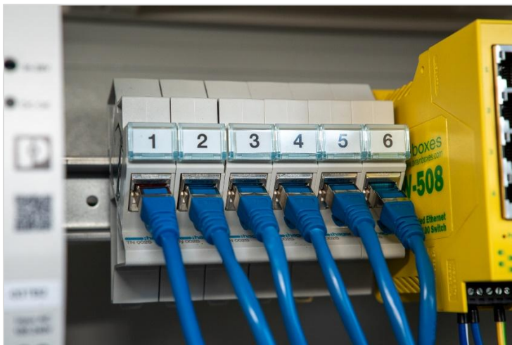
Abbildung 6 - netzwerkseitig nutzbare RJ45-Patchmodule im chargeCLUSTER L
